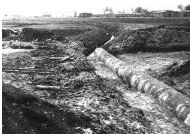
System odwadniający stosowany podczas prac budowlanych na lotnisku
